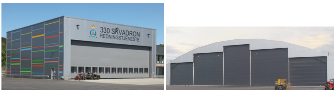
Stålbygg: flyhangar for Norwegian og helikopterhangar for 330 skvadronen ved Florø lufthavn som er kledd med Paroc elementer.
